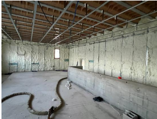
Installation d'isolant thermique des murs dans une maison
